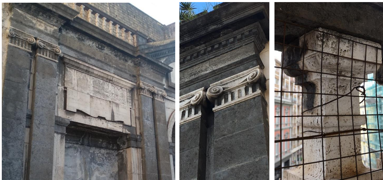
Figura 1 La presenza di croste nere è particolarmente evidente ai lati del prospetto, dove, probabilmente, si crea un ristagno dei moti convettivi del vento, ostacolati dai prospetti degli edifici prospicienti, con conseguente deposito di particelle.
